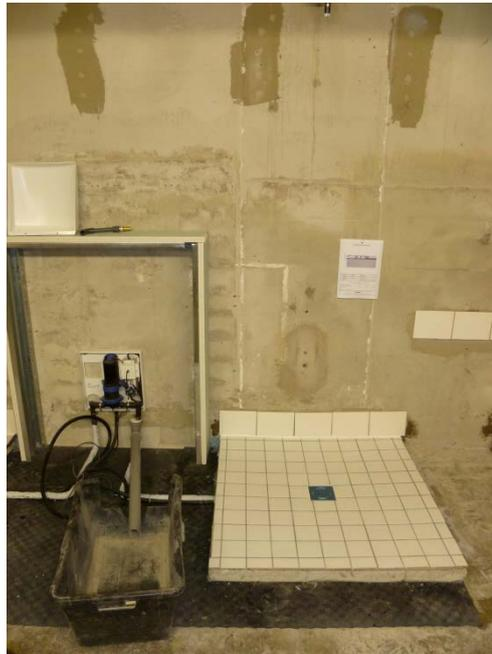
**Bild 3** Oben links: Gewellte Gummigranulatmatte "Schallschutzelement" auf der Rohdecke unterhalb des Bodenablaufs durchgehend im kompletten Estrichbereich verlegt (höhenverstellbare Montagefüße auf der Matte aufgestellt). PVC-U-Rohr und Wellrohr auf Granulatmatte verlegt.
